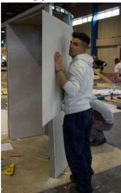
Montaż płyt
