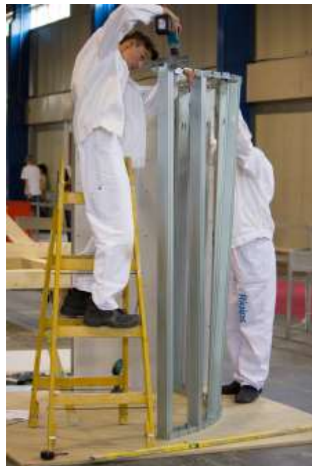
Montaż konstrukcji – węgierski zespół
