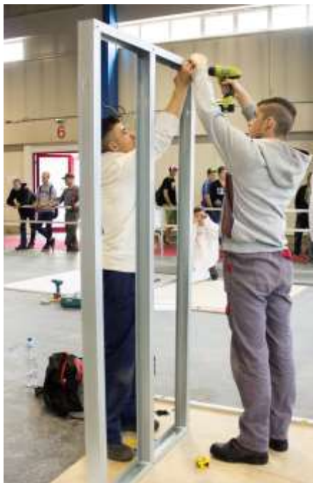
Montaż konstrukcji – słowacki zespół
